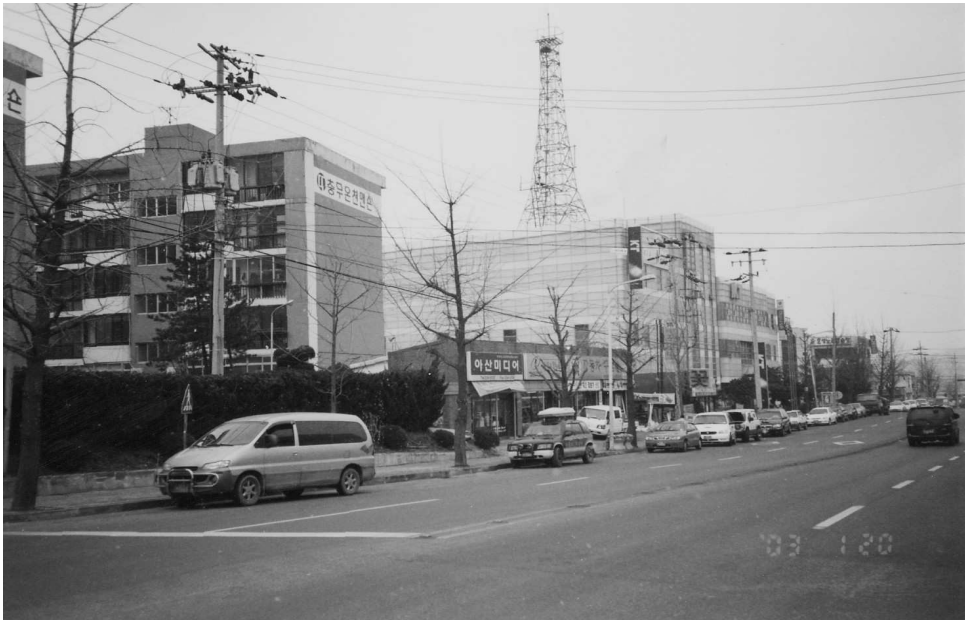
온양온천 시내와 경계를 이루고, 충무교 방향 도로변에 위치. 전신전화국과 민속박물관이 있음
