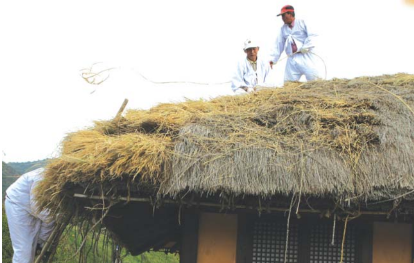
▲이영갈기: 해묵은 지붕을 새로운 이영으로 단장하는 모습.
