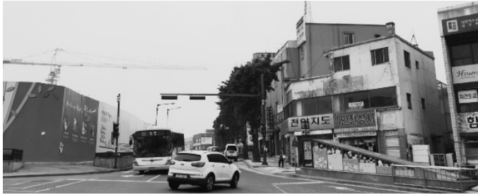
도시재생 사업이 진행되고 있는 천안 원도심. 공공시설과 함께 고층 아파트가 건설되고 있는 옛 시청(현 동남구청) 부지와 낙후된 상업 지구가 마주 보고 있다. (2017년 모습)
