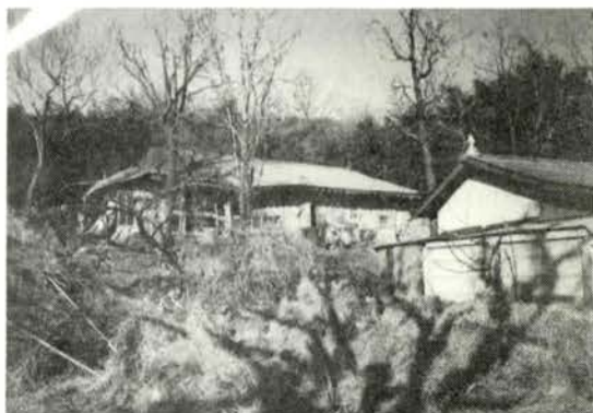
▲ 이병우(李丙雨)씨의 구기(舊基)
