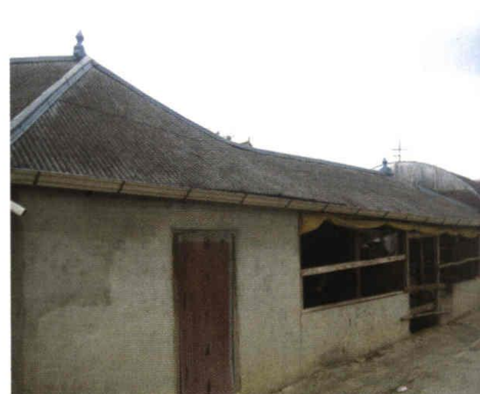
▲ 그림 19 사랑채의 지붕 전경
