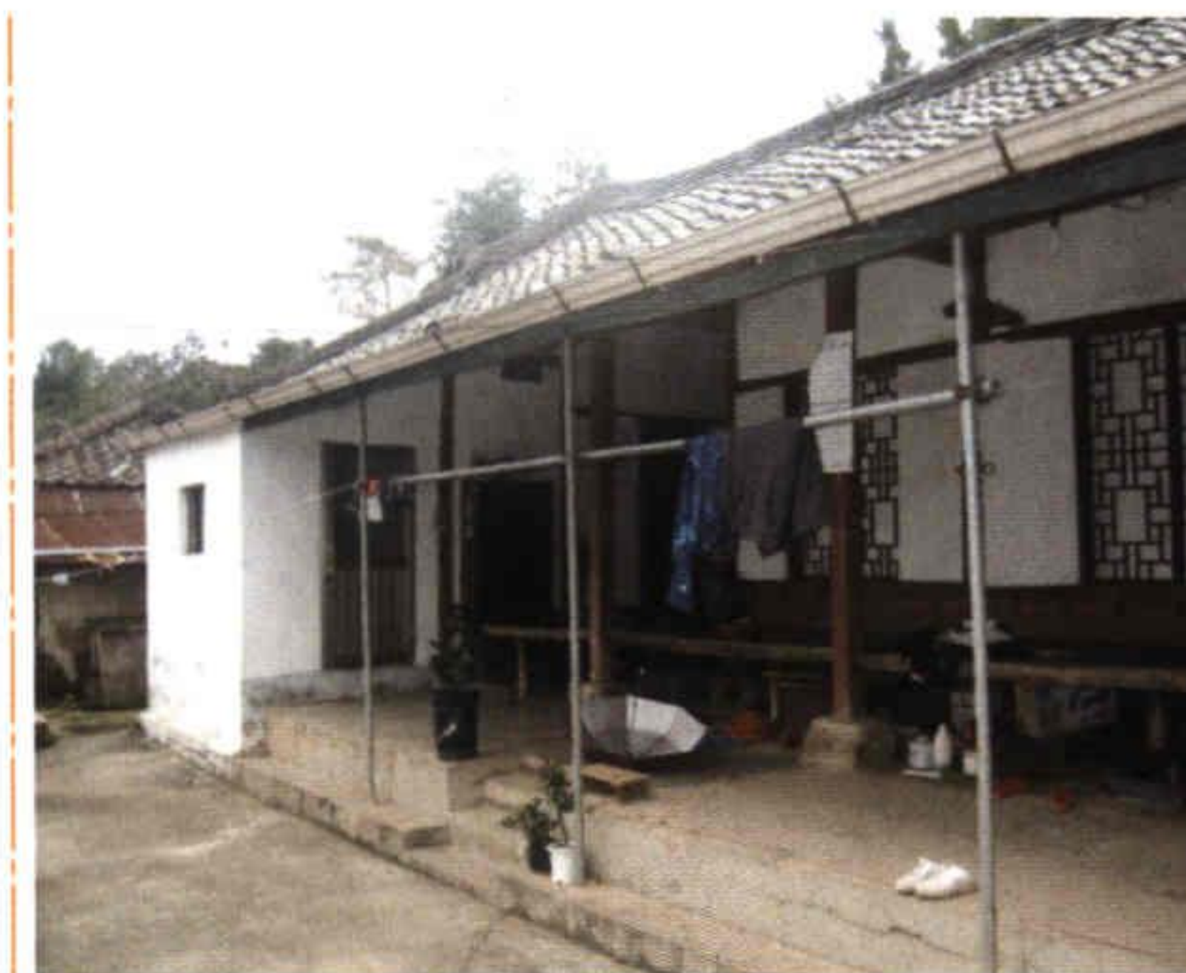
▲ 그림 20 안채의 지붕 전경
