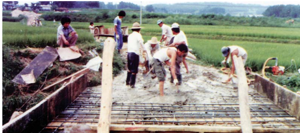
1970년대 음암면 상흥리 새마을사업(교량건설)
